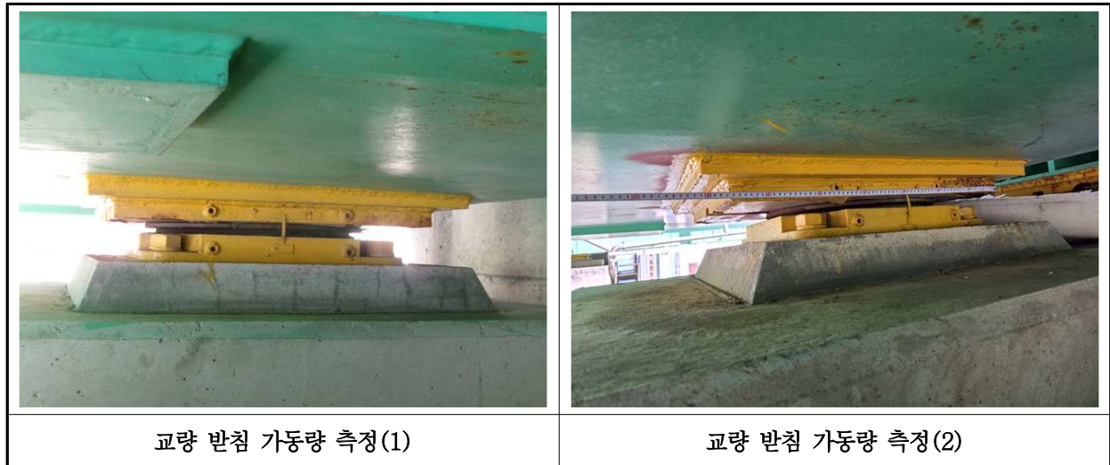
【사진 3.3.16】 교량받침 이동량 측정
