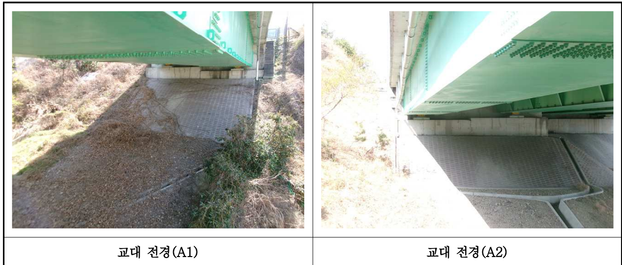
【사진 3.3.8】 교대 전경
