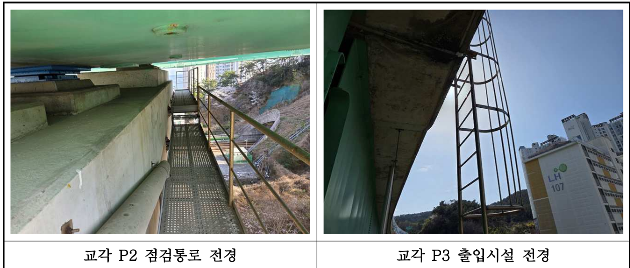
【사진 3.3.26】 교량 점검시설 전경
