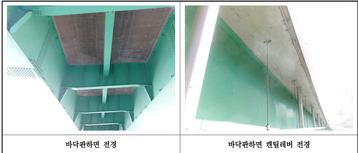
【사진 3.3.2】 바닥판하면 전경
